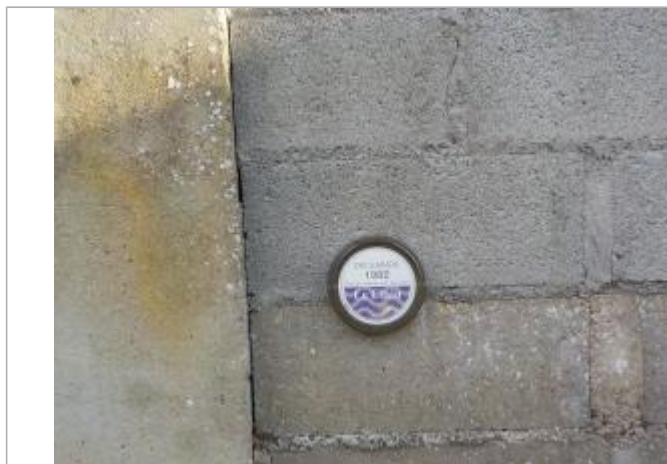
Photos du repère NAIN30-R. Source : 3DI
