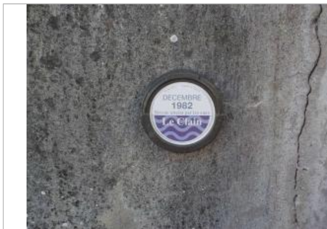
Photos du repère NAIN12-R. Source : 3DI
