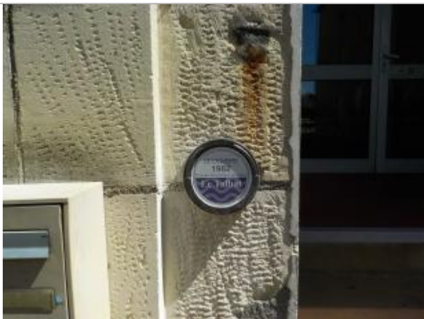
Photos du repère CHAU12-R. Source : 3DI
