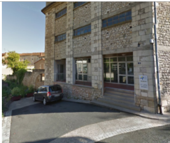
Ancienne graineterie de Chauvigny - bâtiment du Conseil Général de la Vienne
