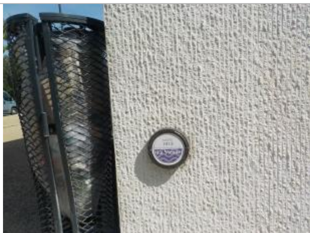
Photos du repère CHAT30-R. Source : 3DI
