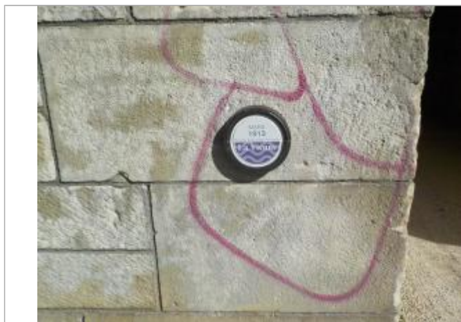
Photos du repère CHAT24-R. Source : 3DI
