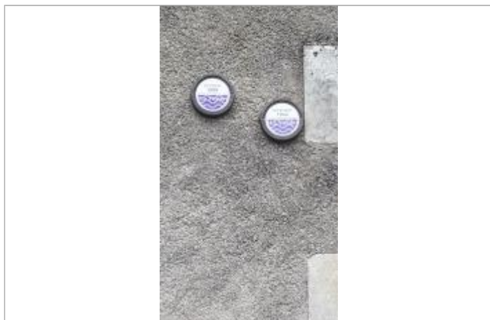
Photos du repère MATO24-R. Source : 3DI
