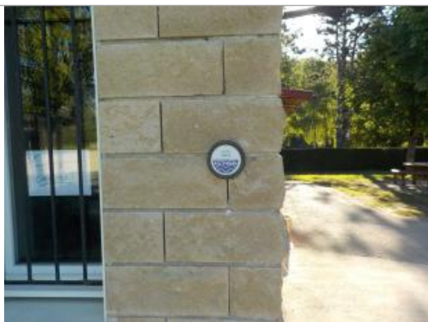
Photos du repère MATO21-R. Source : 3DI
