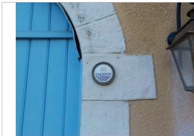
Photos du repère MATO20-R. Source : 3DI
