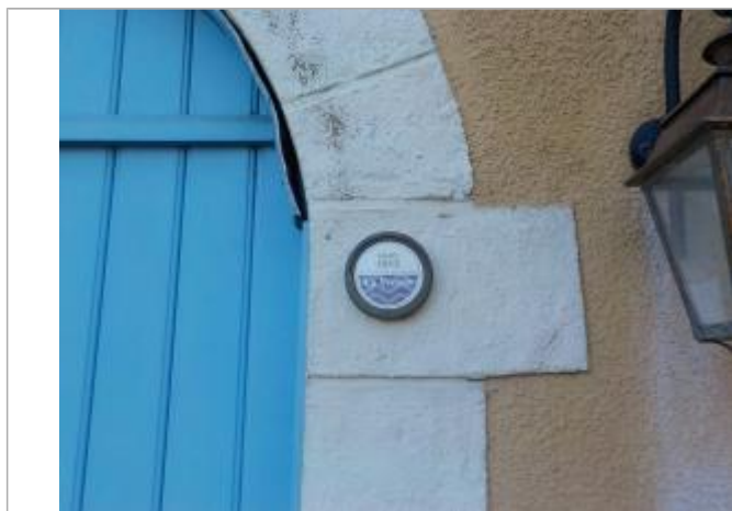
Photos du repère MATO20-R. Source : 3DI
