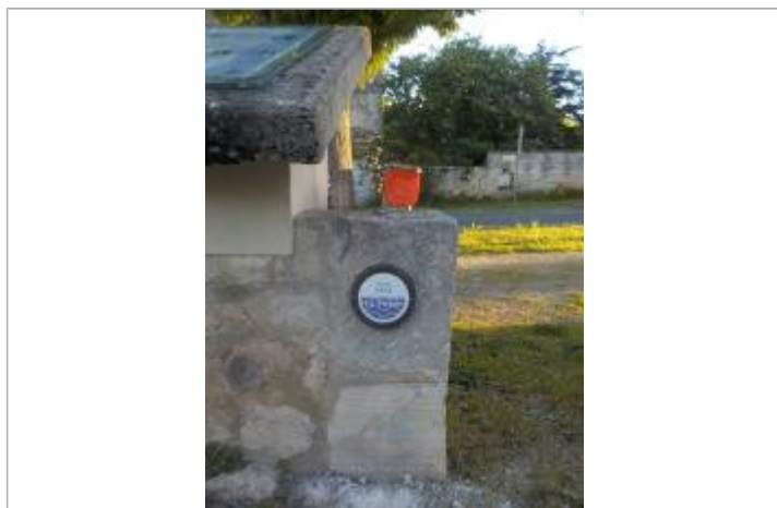
Photos du repère MATO19-R. Source : 3DI
