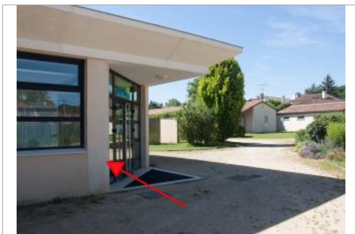
Photos du site BONN48-R. Source : EPTB Vienne
