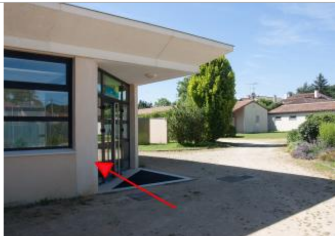
Photos du site BONN48-R. Source : EPTB Vienne
