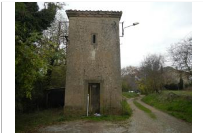
Vue du site
