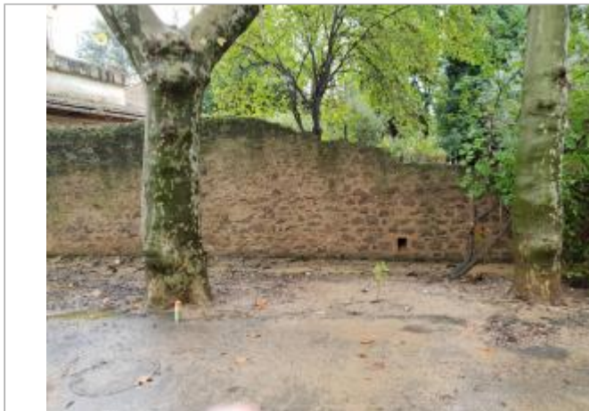
Vue du site
