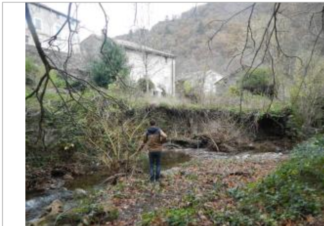
Vue du site
