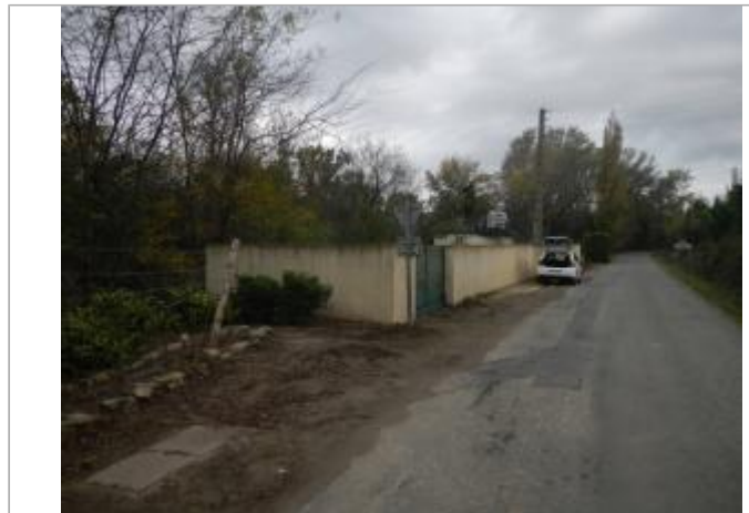
Vue du site
