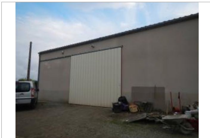
Vue du site
