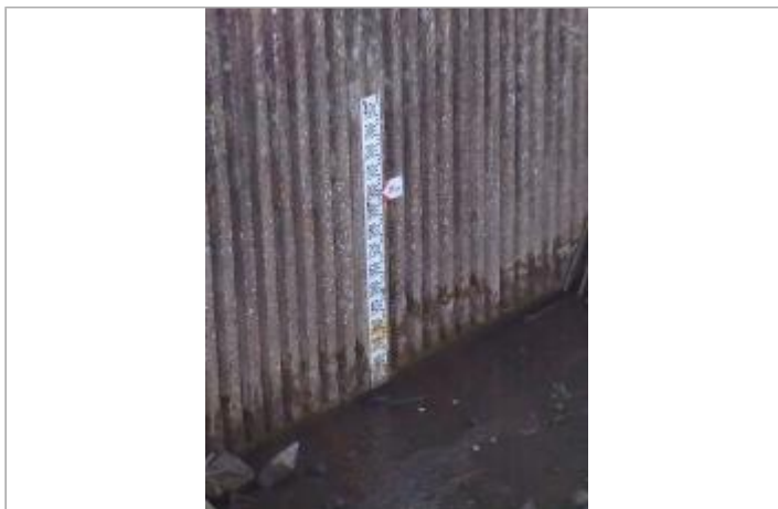
Echelle de sortie du bassin des Près de l'Étang
