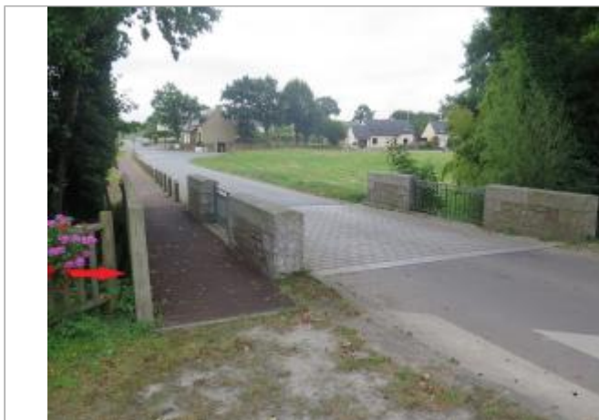
Vue d'ensemble du site
