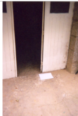
Porte du garage de l'habitation (19/01/2001)
