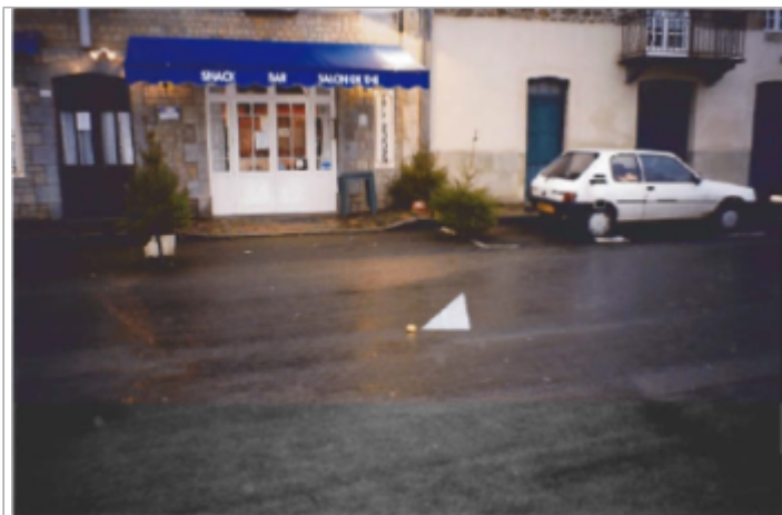
Vue de la route devant 57 rue du Quai (19/01/2001)
