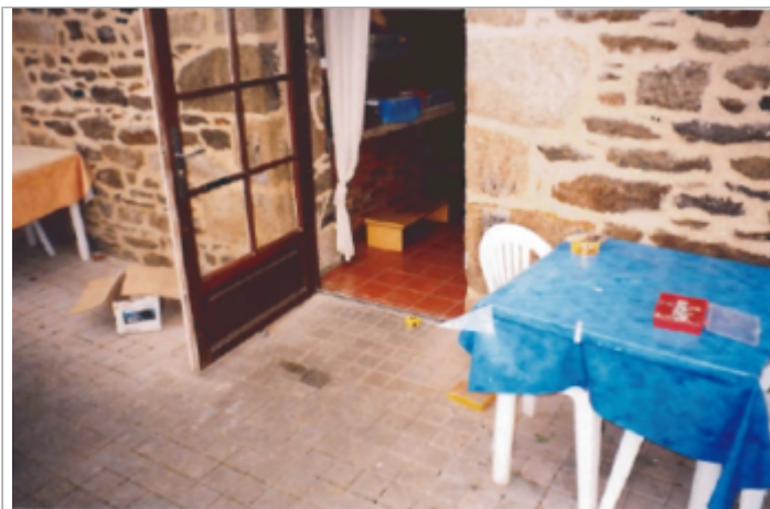
Porte de la terrasse du restaurant (19/01/2001)
