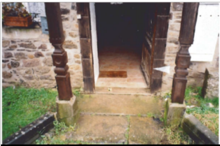
Porte d'entrée de l'habitation (19/01/2001)
