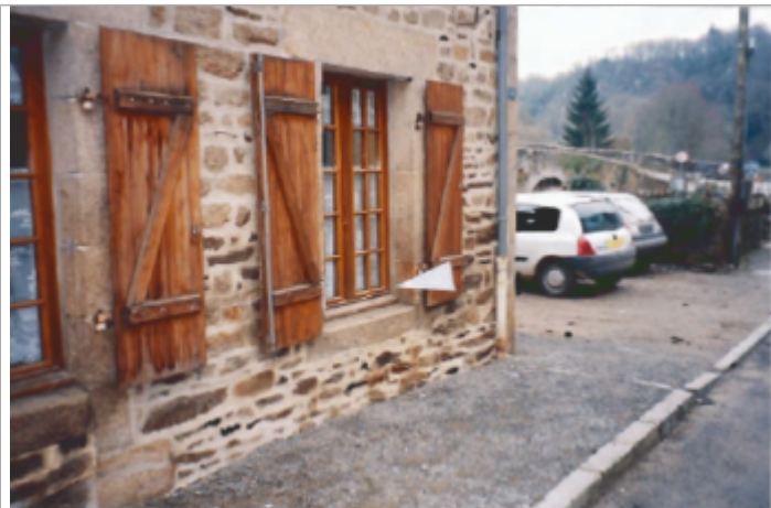
Facade du bâtiment d'habitation (19/01/2001)
