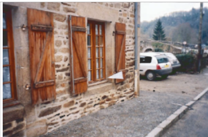
Facade du bâtiment d'habitation (19/01/2001)
