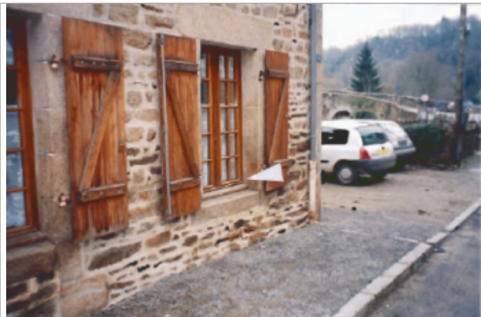
Facade du bâtiment d'habitation (19/01/2001)
