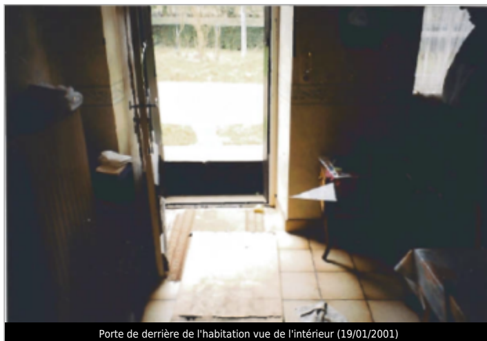
Porte de derrière de l'habitation vue de l'intérieur (19/01/2001)
