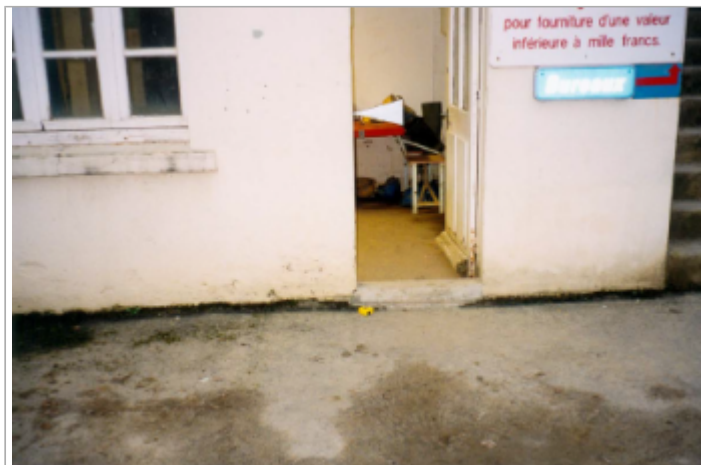
Porte des vestiaires ( 19/01/2001)
