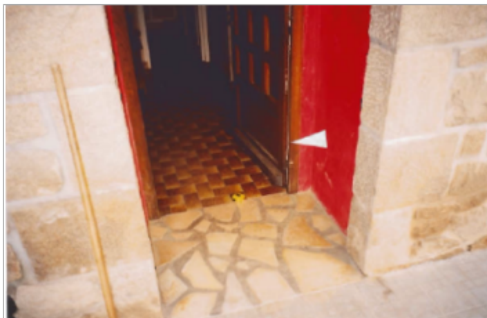
Porte d'entrée de l'habitation (19/01/2001)
