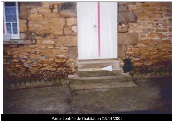
Porte d'entrée de l'habitation (19/01/2001)
