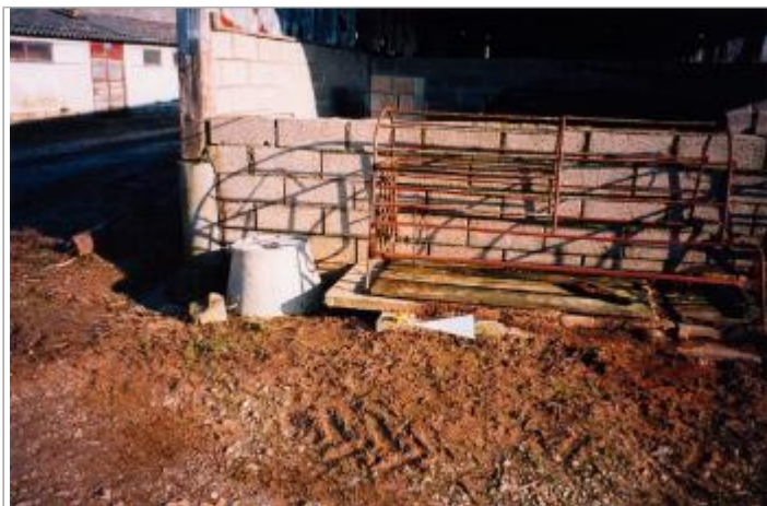
Photographie de l'arrière du hangar (19/01/2001)
