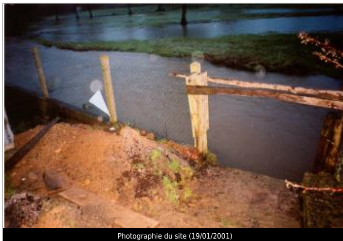
Photographie du site (19/01/2001)
