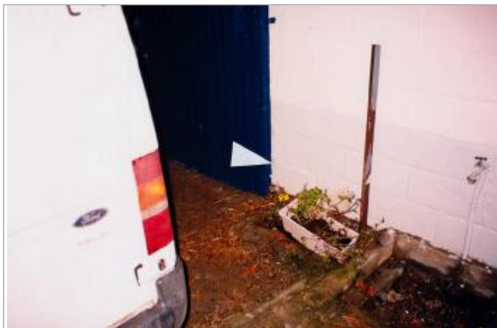
Laisse de crue devant le hangar ( 19/01/2001)
