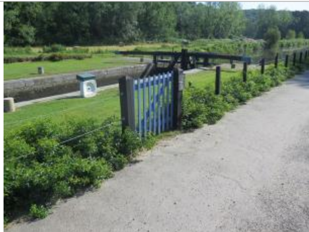
Portail en face de la maison éclésièrre
