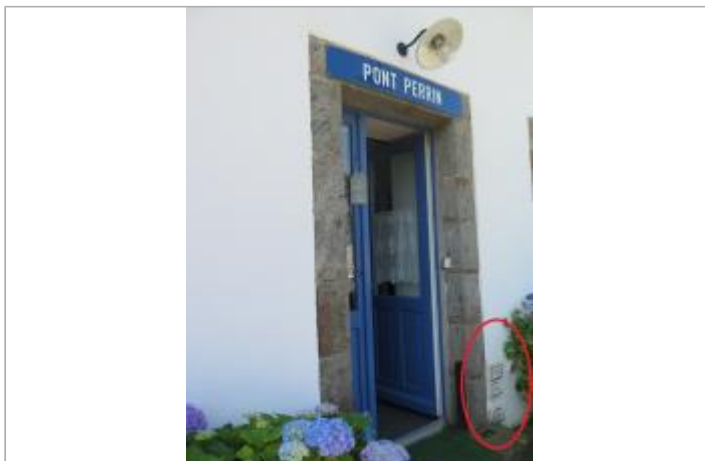
Vue d'ensemble de l'entrée de la maison éclusière
