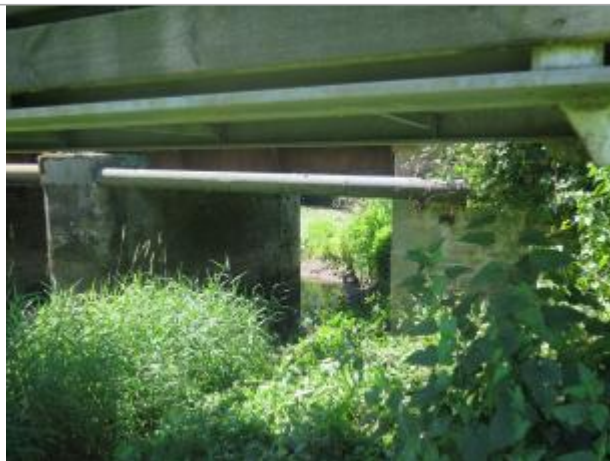
Vue du dessous du pont
