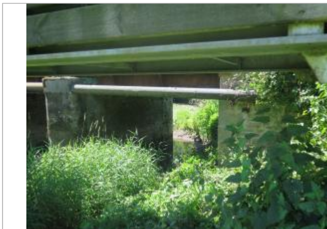
Vue du dessous du pont
