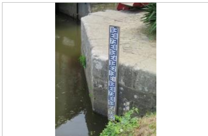
Echelle limnimétrique à l'amont de l'écluse de La Bouexière à Guichen
