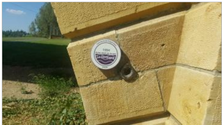
Vue du repère - Auteur : EPIDOR
