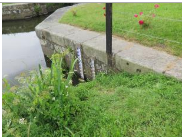
Echelle limnimétrique à l'amont de l'écluse de Cicé à Bruz
