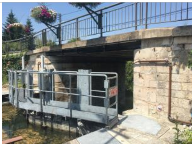
Repère de crue VNF sur la pile de pont à l'aval rive droite de l'écluse
