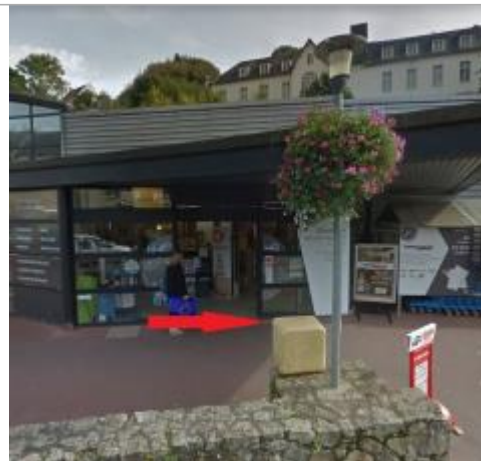
Vue d'ensemble de la façade de la grande surface
