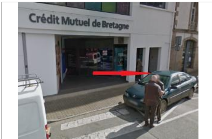
Façade du bâtiment
