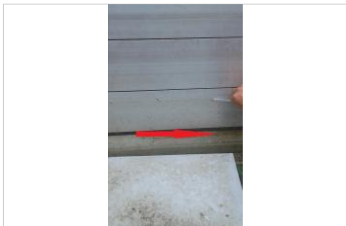
Rebord béton extérieur toilettes publiques
