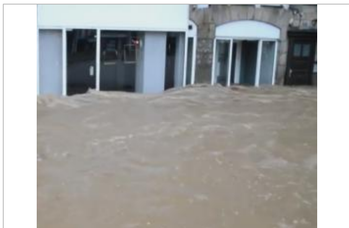
Photographie du site lors de l'inondation
