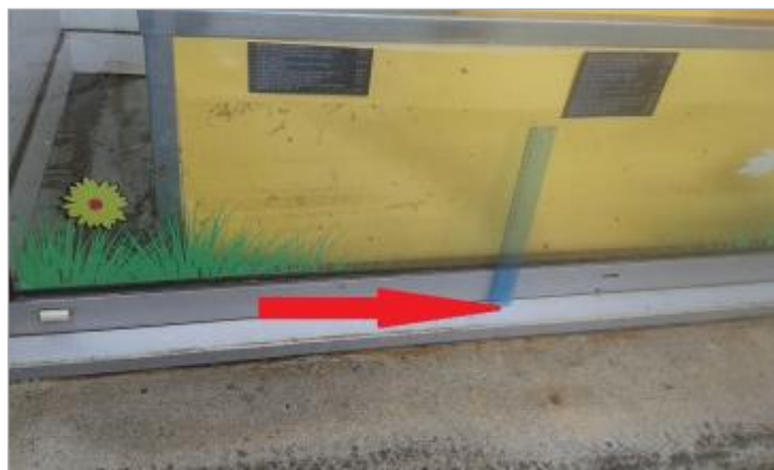
laisse de crue du niveau atteint à l'intérieur du magasin
