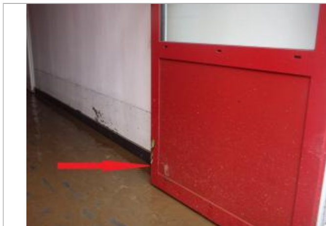
laisse de crue à l'intérieur du bâtiment
