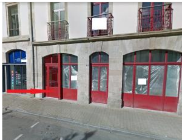
Vue d'ensemble de la façade du bâtiment
