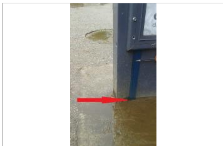
Laisse de crue à l'intérieur de l'arrêt de bus. Le crayon indique le niveau atteint par l'eau.
