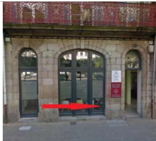
Vue d'ensemble de la façade du bâtiment
