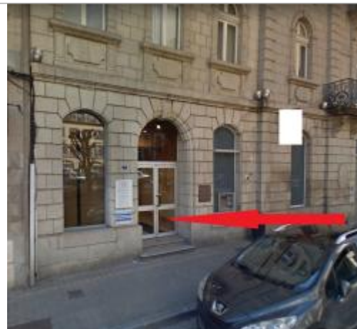
Vue d'ensemble de la façade du bâtiment
