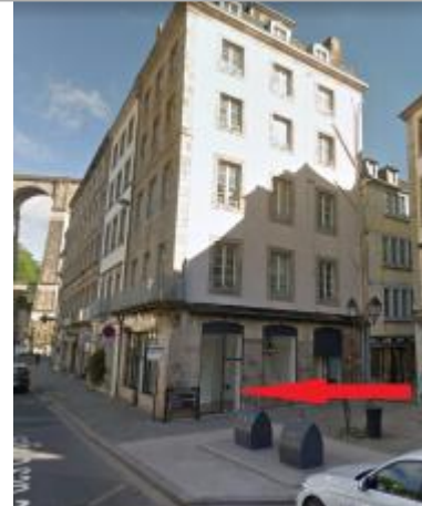
Vue d'ensemble de la façade du bâtiment
