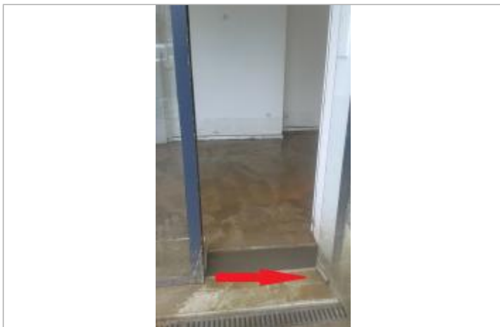
seuil à droite de la porte vitré du bâtiment n°8
