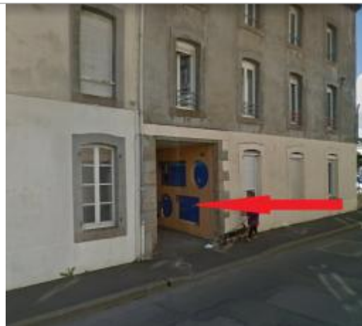
Vue d'ensemble du site
