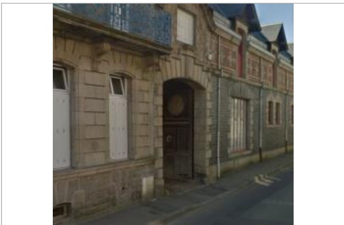
Vue d'ensemble de la façade du bâtiment
