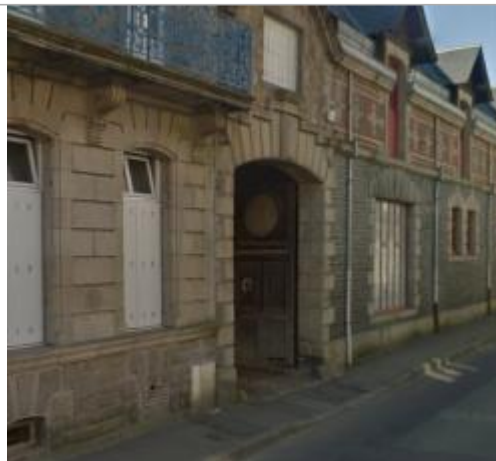
Vue d'ensemble de la façade du bâtiment
