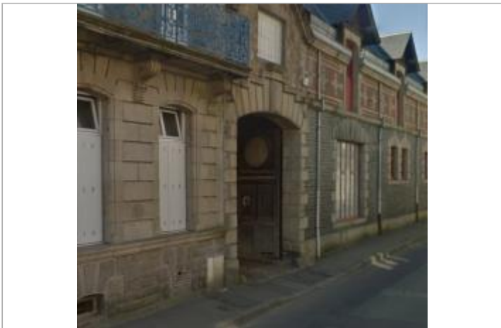
Vue d'ensemble de la façade du bâtiment
